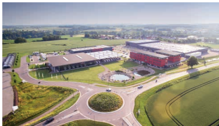
Werk Aulendorf Fertigungsstätte der Baureihen chic e-line, chic s-plus und liner-for-two
