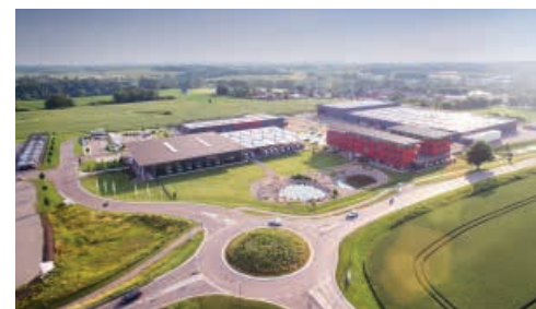
Unternehmenszentrale Aulendorf - seit 2013
