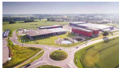
Unternehmenszentrale Aulendorf - seit 2013
